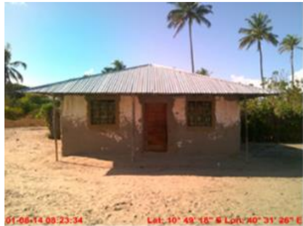
Figura 3-24: Exemplo de materiais modernos utilizados para a construção de habitações
